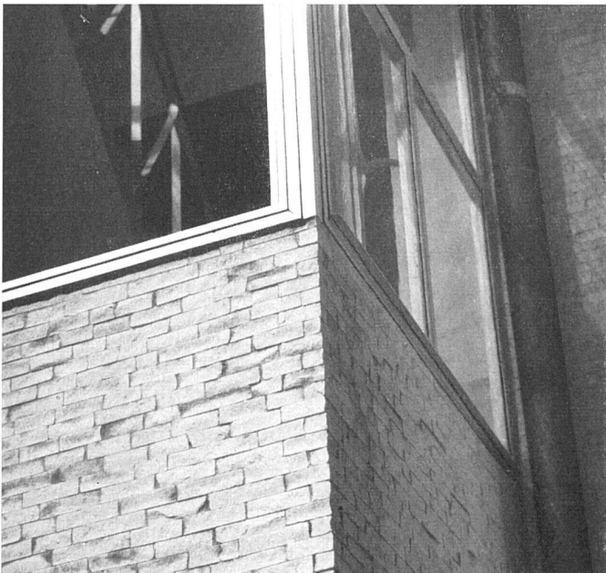
Fassadenverkleidung. Maschinengebrochene Carrara-Marmorstücke, 70 × 35 mm, 30 bis 50 mm tief | Les façades sont revêtues de petites pièces de marbre de Carrare | The elevations are clad with small pieces of Carrara marble
