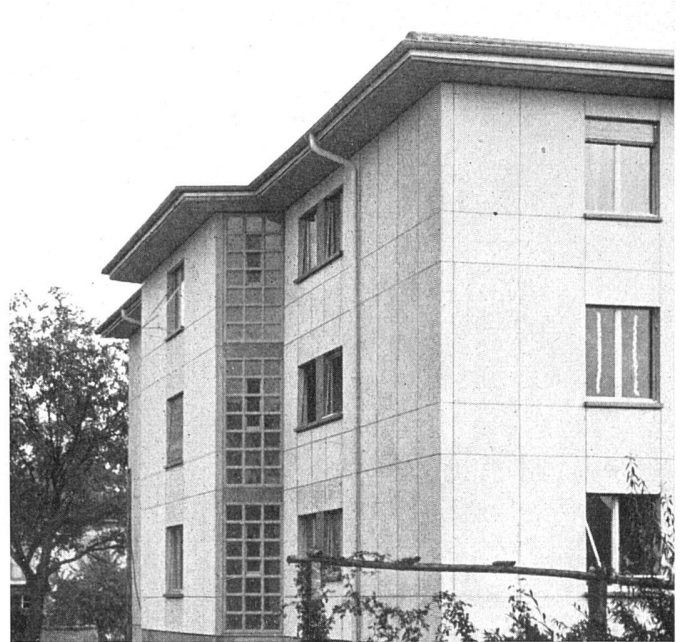
Façade postérieure et corps d'escalier | Rückfassade mit Treppenhaus | Rear elevation with staircase
