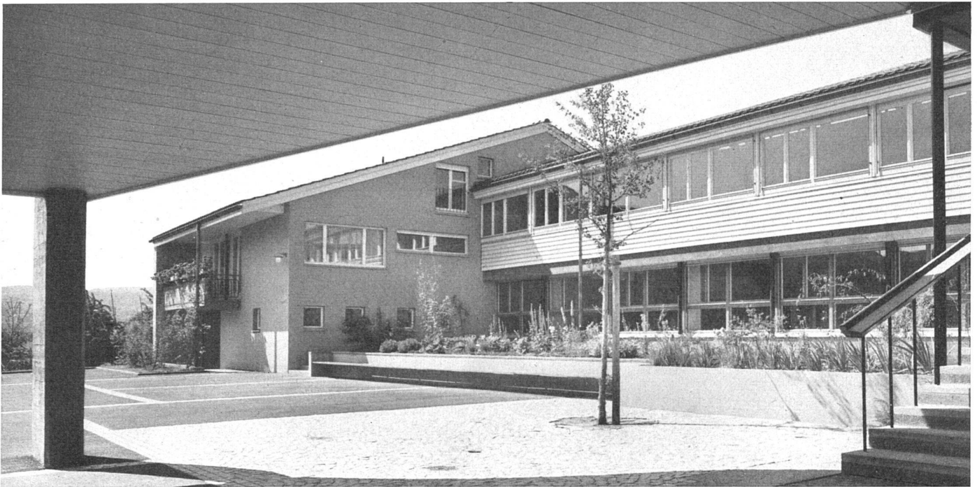
Verbindungsbau und Westbau mit Kräutergarten von der Pausenhalle aus gesehen | Extérieur de la salle des sciences naturelles et de l'appartement du concierge | Exterior of natural science room and caretaker's apartment
