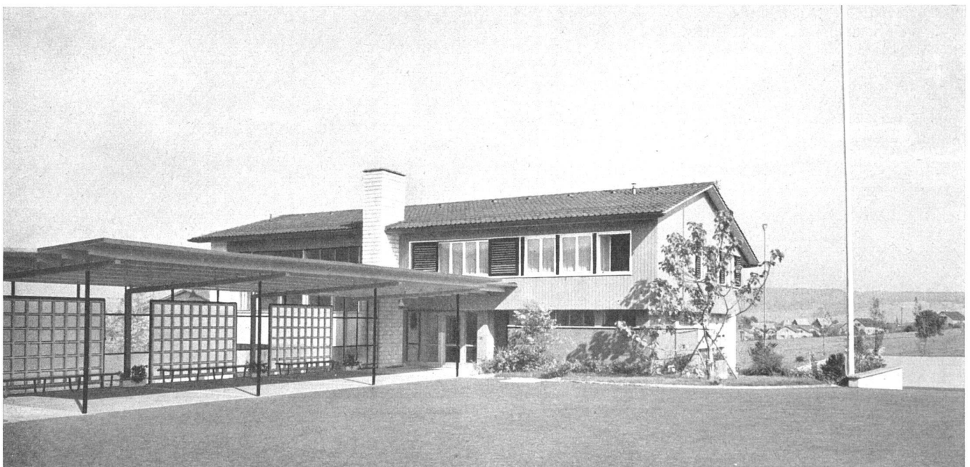
Pausenhalle und Nebengebäude / Passage couvert et bâtiment annexe / Covered passage and annex
