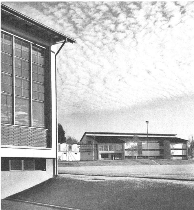
Turnhallecke und Klassentrakt von Norden | Détail de la salle de gymnastique, au fond, l'aile des classes | Corner of gymnasium and classroom wing from the north
