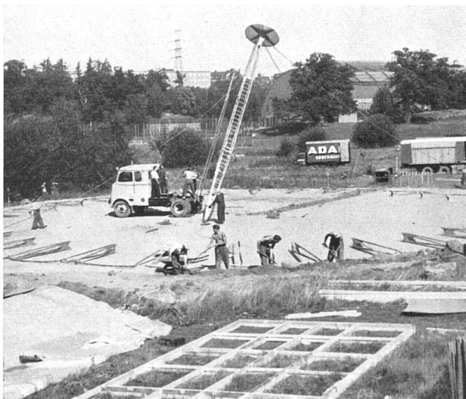
Der Zeltmast wird aufgerichtet | Le mât de la tente est planté | The tent's mast being erected
