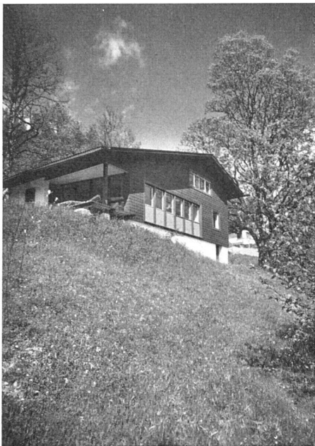
Südwestansicht | Vue prise du sud-ouest | From south-west
