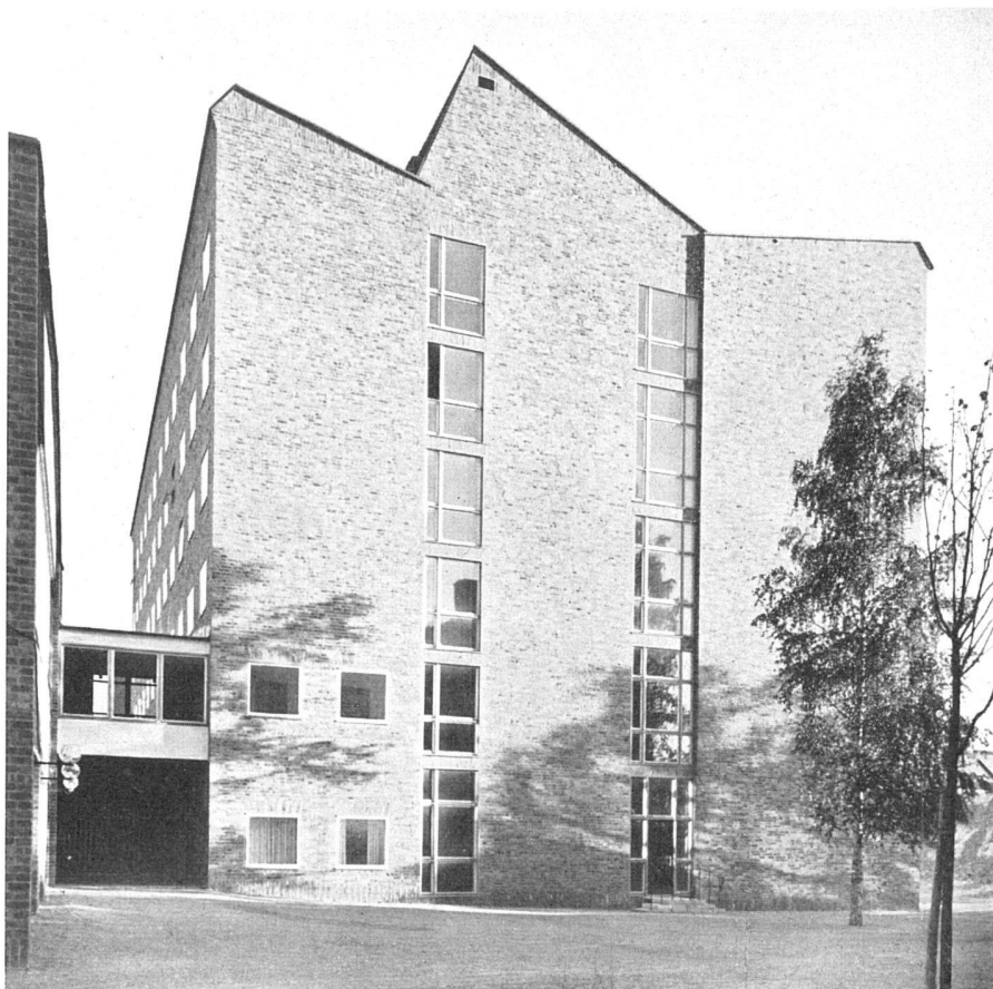
Giebelseite mit Sheddach über dem Lichthof | Hall central et toit formé de sheds, au-dessus de la cour | Gable side with shed-roof over court
