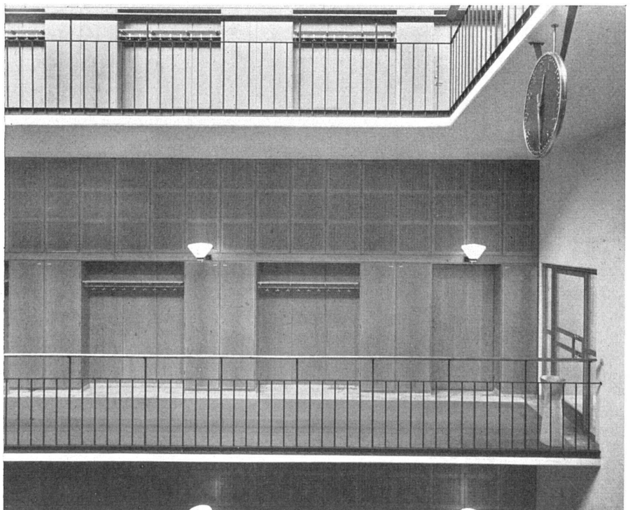
Galeriewand gegen Zeichnungssaal in Eichentäfer mit Nischen für Gardero- ben- und Zeichenschränke. Über den Nischen geschlitztes Täfer für Schall- absorbierung. Boden in Korklinoleum zwischen Friesen aus Marmor | Paroi de la galerie vers la salle de dessin; dans les niches, placards à vêtements et armoires à dessins | Gallery wall towards drawing room with niches for wardrobes and drawing cupboards
