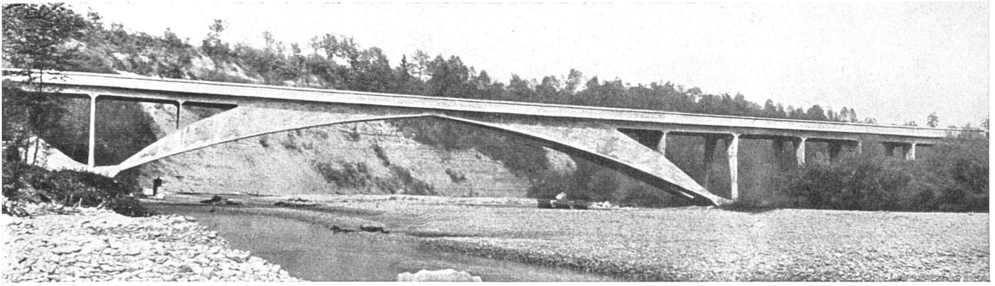
Robert Maillart, Thurbrücke bei Henau-Uzwil | Pont de la Thur près de Henau-Uzwil | Bridge crossing the Thur near Henau-Uzwil Aus: Max Bill, Robert Maillart. Verlag für Architektur AG., Erlenbach-Zürich 1949
