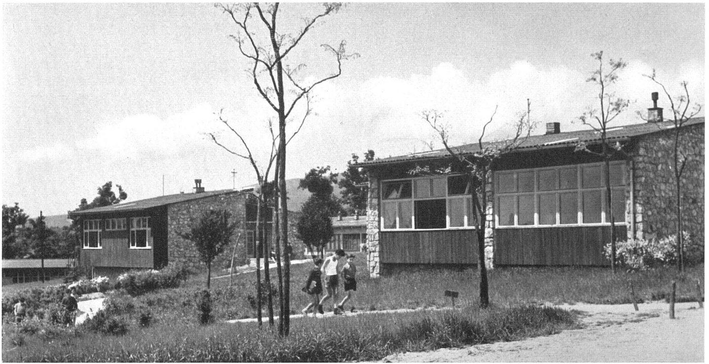
Die Pavillons wurden unter Mithilfe der Jugendlichen aus Bruchstein und Holz gebaut | Les pavillons ont été construits avec l'assistance de la jeunesse | The pavilions were built with the help of youth Photos: M. Grcević
