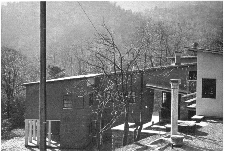
Wohnhaus und Mittelbau dunkelrot getönt, als Kontrast zu den weißen Schlafpavillons | Maison d'habitation et bâtiment central sont peints en rouge sombre, contrastant avec le blanc des dortoirs | Day-pavilion and central building in dark red, in contrast to the white dormitories
