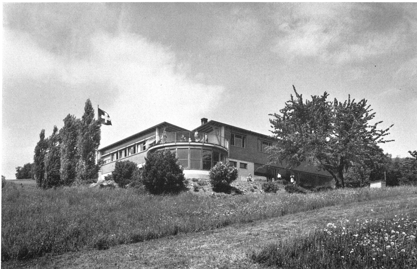
Gesamtanlage von Südosten | L'ensemble vu du sud-est | General view from South-East
