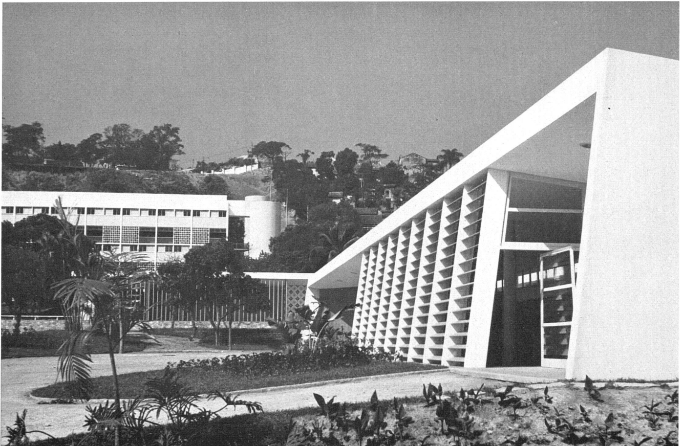
Ansicht von Westen, rechts Marktgebäude, links Sanitätsstation, Wohnblock B | Vue prise de l'ouest; à droite le marché, à gauche le centre médical et les immeubles B | From west, at right, the market, at left, the medical center and block B
