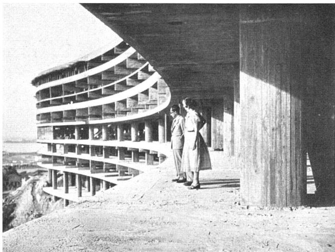
Block A, Zugangs- und Promenadegalerie | Immeuble A, galerie d'accès | Block A, access gallery
