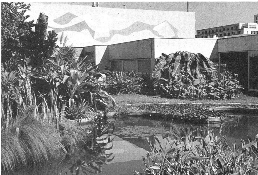
Dachgarten Bau «Reseguros» (Gebr. Roberto, Architekten) | Toit-jardin | Roof-garden
