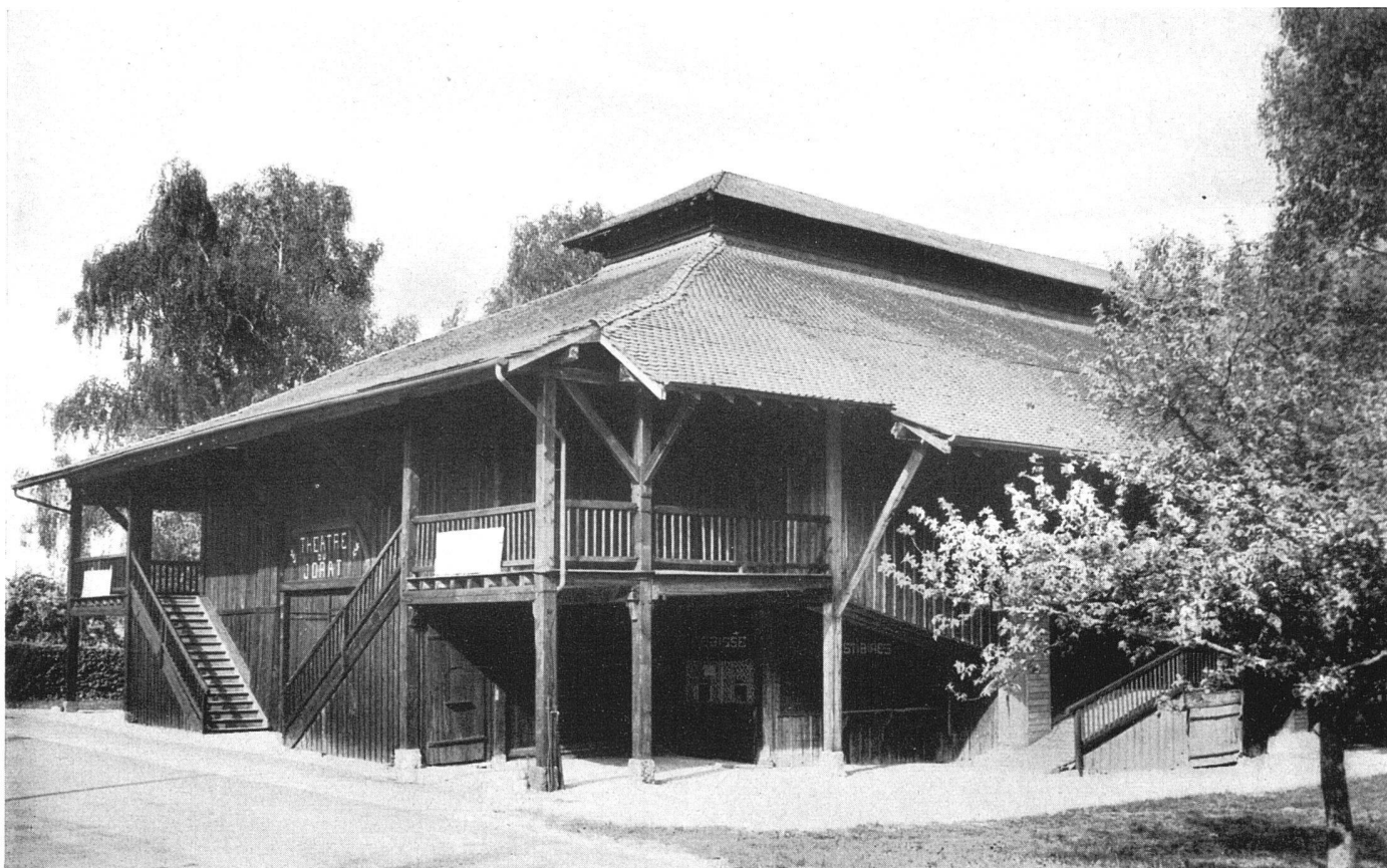
Théâtre du Jorat, Seitenansicht mit Aufgängen zum erhöhten Teil des Saales; offene Foyers oben und unten | Extérieur avec accès à la partie supérieure de la salle, foyers ouverts | Exterior with open staircases leading to the upper part of the auditorium
