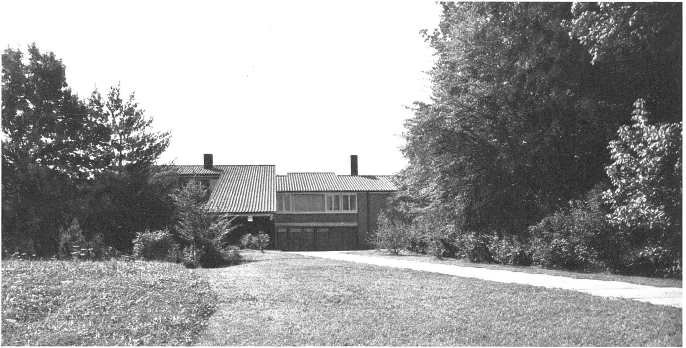
Gesamtansicht von Norden, das Haus schön gefaßt durch die vorhandenen Bäume / Vue d'ensemble prise du nord, façade de l'entrée / General view from the north showing the entrance elevation Photos: H. Herdegs Erben; Aufnahmen: W. Binder, Zürich
