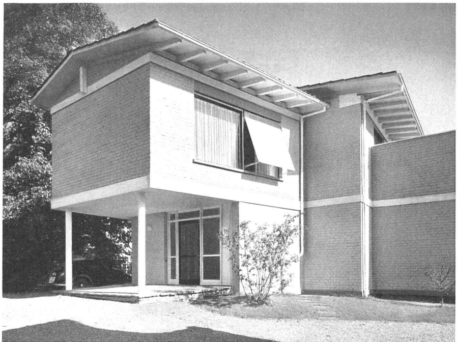
Eingangspartie, im Obergeschoß das Elternzimmer. Fassaden aus geschlemmten Zürcher Backsteinen, hellgrau gestrichen, Beton weiß | L'entrée de la maison | The entrance of the house
