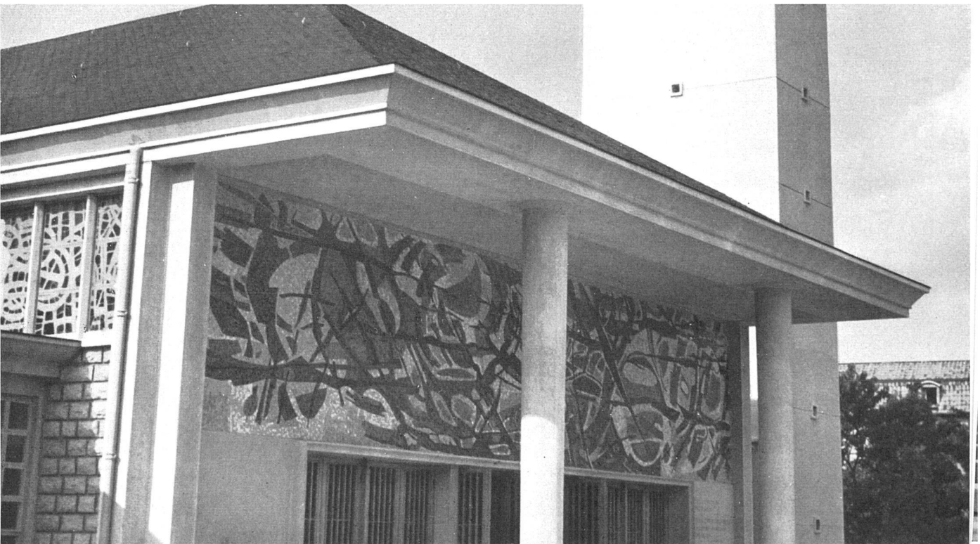
Eingangsfassade mit Mosaik von Jean Bazaine / Entrée et mosaïque de Jean Bazaine / Entrance elevation and mosaic by Jean Bazaine
