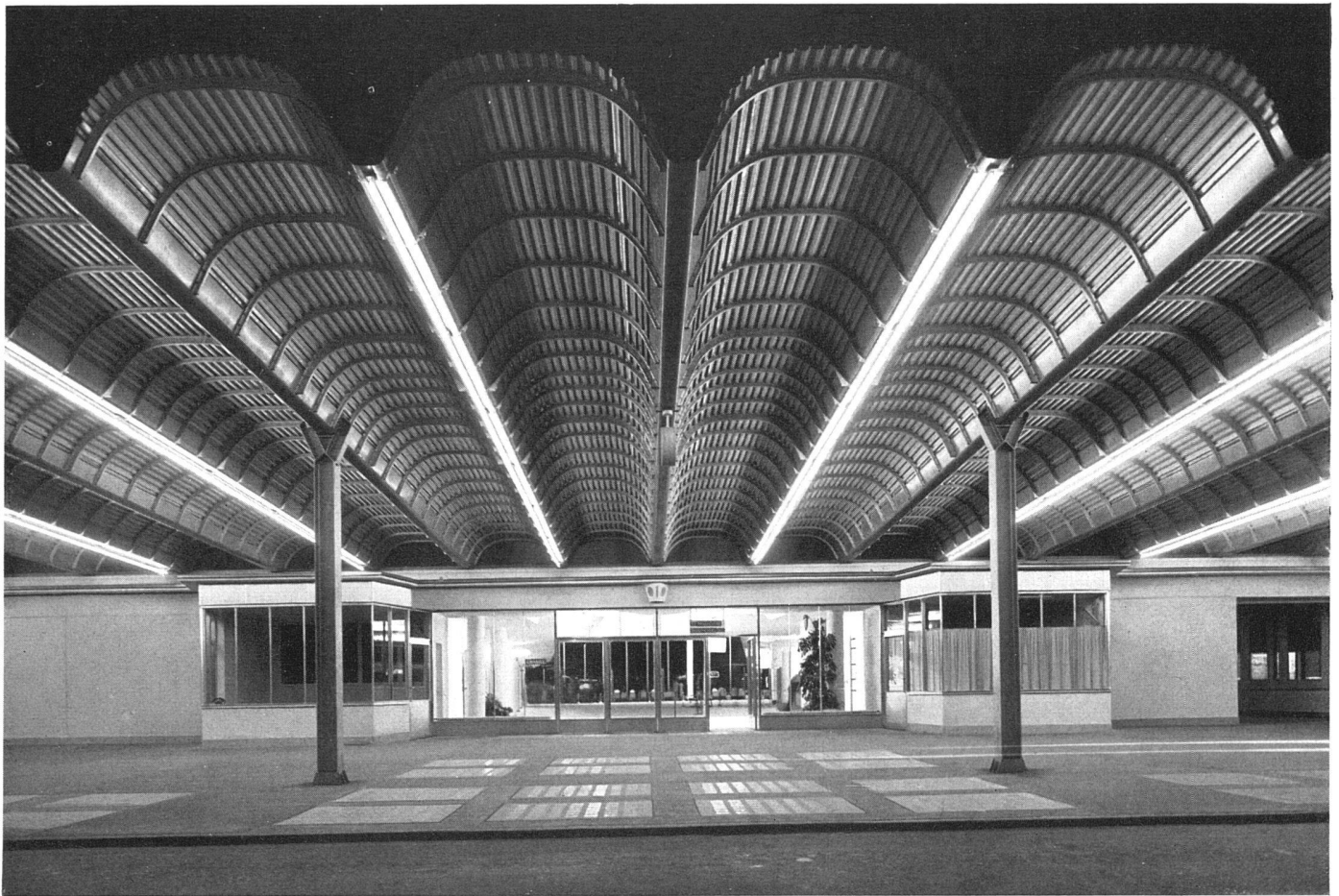
Eingang für abfliegende Passagiere, Konstruktion in Aluminium | L'entrée pour le départ des passagers | Departing passengers' entrance Photo: F. Engesser, Zürich
