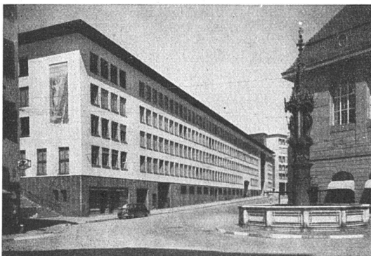
Polizei-Verwaltungsgebäude Spiegelhof Basel Von der Mühl & Oberrauch, Architekten, Basel
