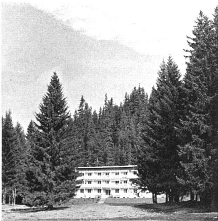
Von Süden | Vue prise du sud | From the south
