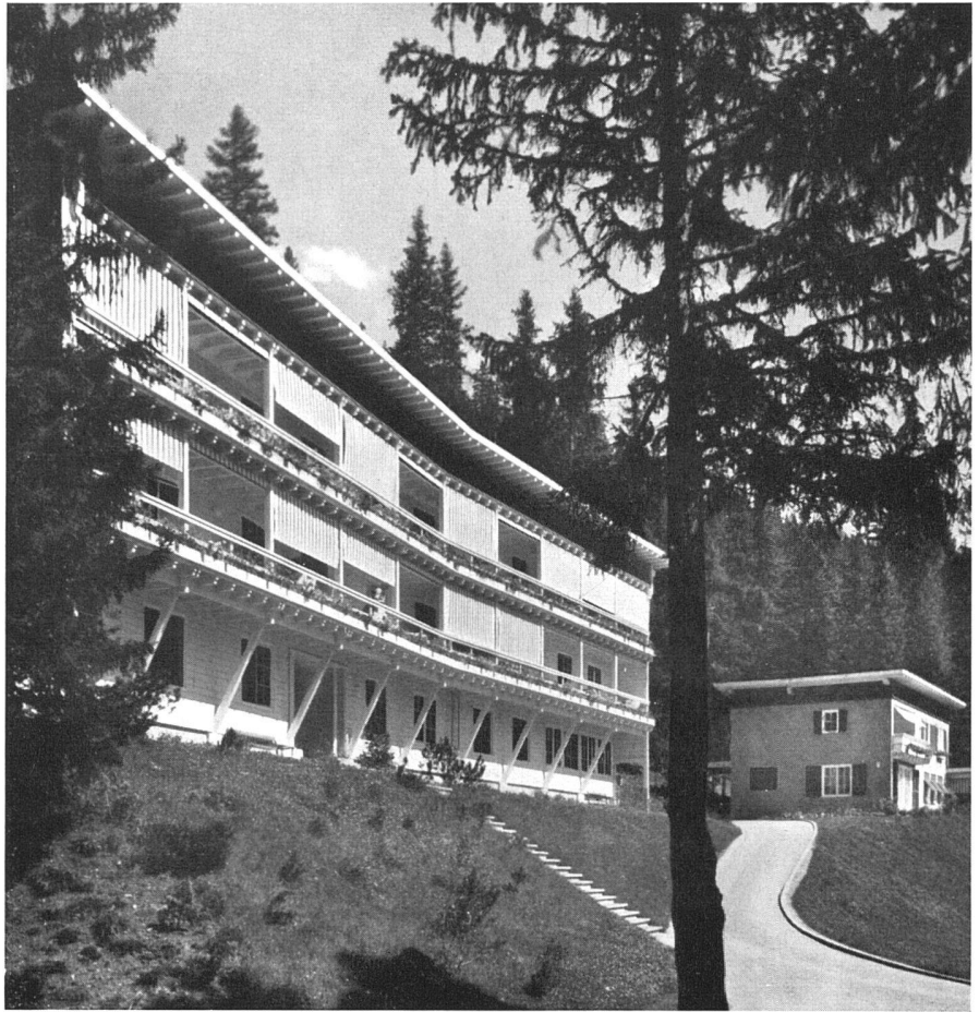
Angestelltenhaus und Direktorhaus von Südwesten | La maison du personnel et la villa du directeur; vue prise du sud-ouest | The employees' dormitory and the director's house from the south-west
