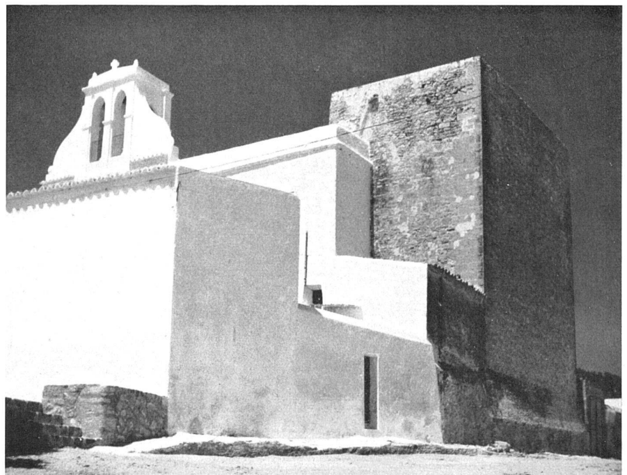
Kirche in San Antonio. Der Raum wird durch den Vorhof betreten und erhält sein Licht nur durch Türe und rückwärtiges Fenster | Eglise à San Antonio; la lumière n'y pénètre que par la porte et une petite fenêtre | Church at San Antonio, lit only by the door and a small window
