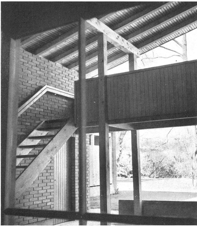
Haus in Cademario. Ausgang zum Gästeeapartment | L'accès de l'appartement des hôtes | Staircase leading to the guest apartment
