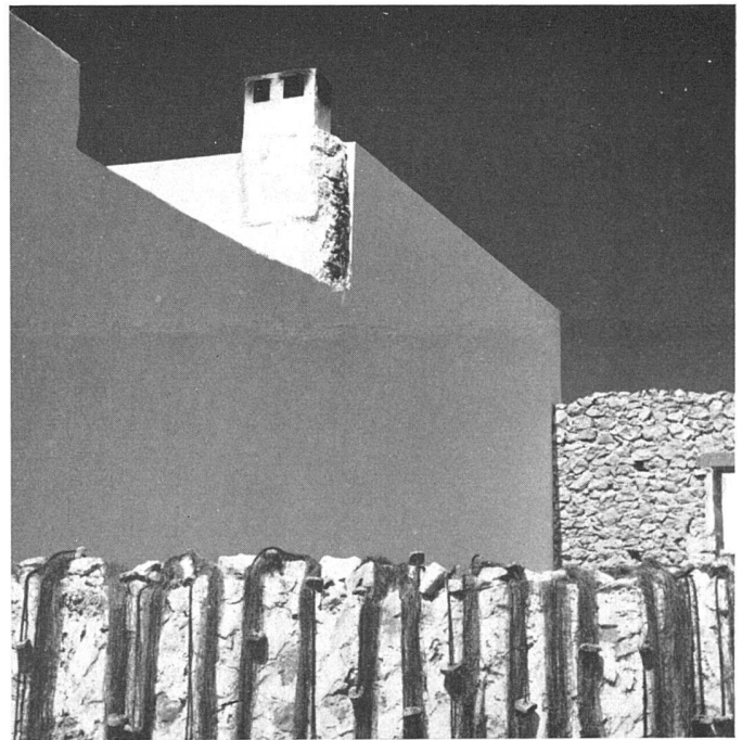
Hausmauer in San Antonio | Mur d'une maison à San Antonio | House wall at San Antonio
