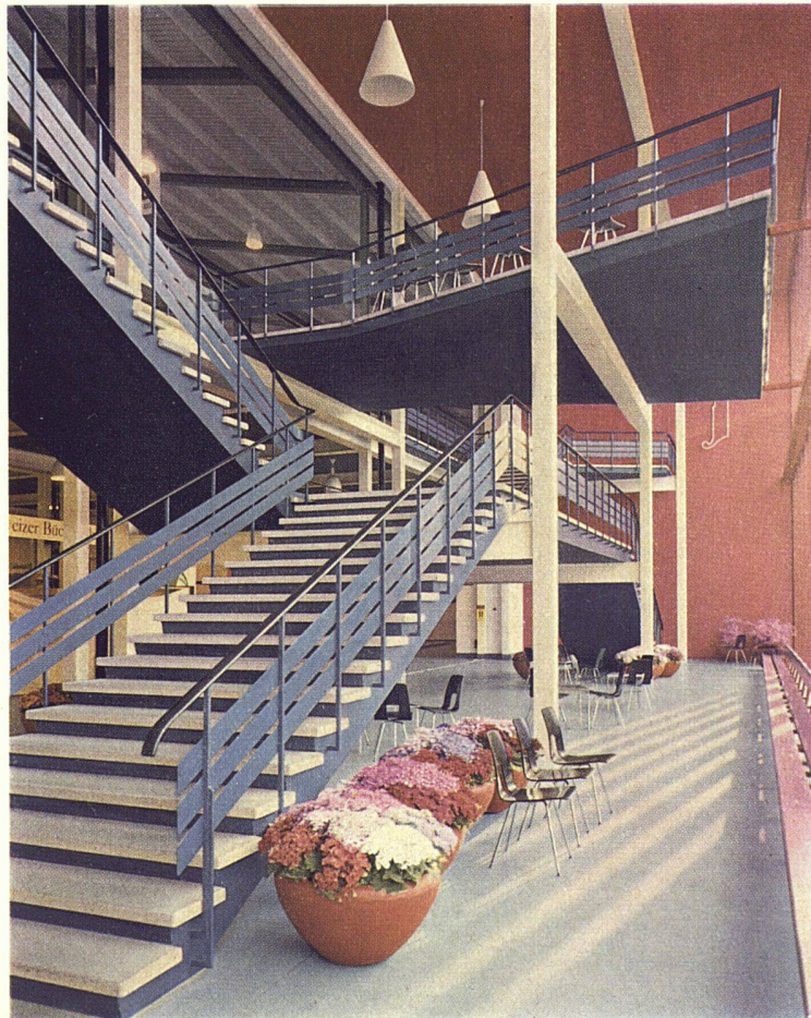
Mittelhalle über Haupteingang als Ruheraum, Treppe vom ersten zum zweiten Obergeschoß. Eisenbeton- platte auf Stahlkonstruktion, Stufen Kunststein, Boden grüner Durotexbelag / Hall du premier, au-dessus de l'entrée principale / Hall above main entrance with stairs leading to the second upper floor
