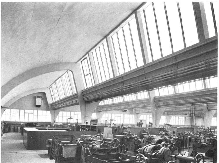
Inneres des Shedbaus / Intérieur / Interior
