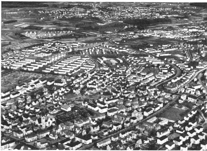
Vorstadtgebiet mit einförmiger additiver Bebauung, nur in der Mittelzone Ansätze bewußter Gliederung | La monotonie fréquente de nos banlieues est tout le contraire d'un Heimatschutz vivant | Monotonous suburban development
