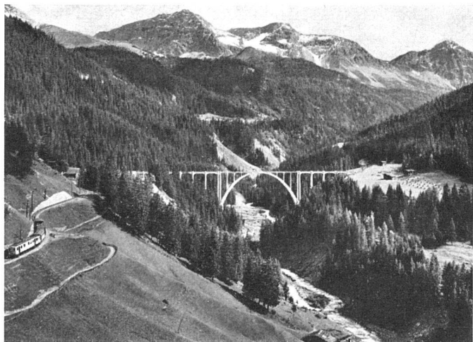
Gut geformte technische Bauten bereichern das Landschaftsbild. Langwies-Viadukt der Chur-Arosa-Bahn | Ce viaduc en béton armé ajoute à la beauté du paysage | Harmony between landscape and well designed civil engineering
