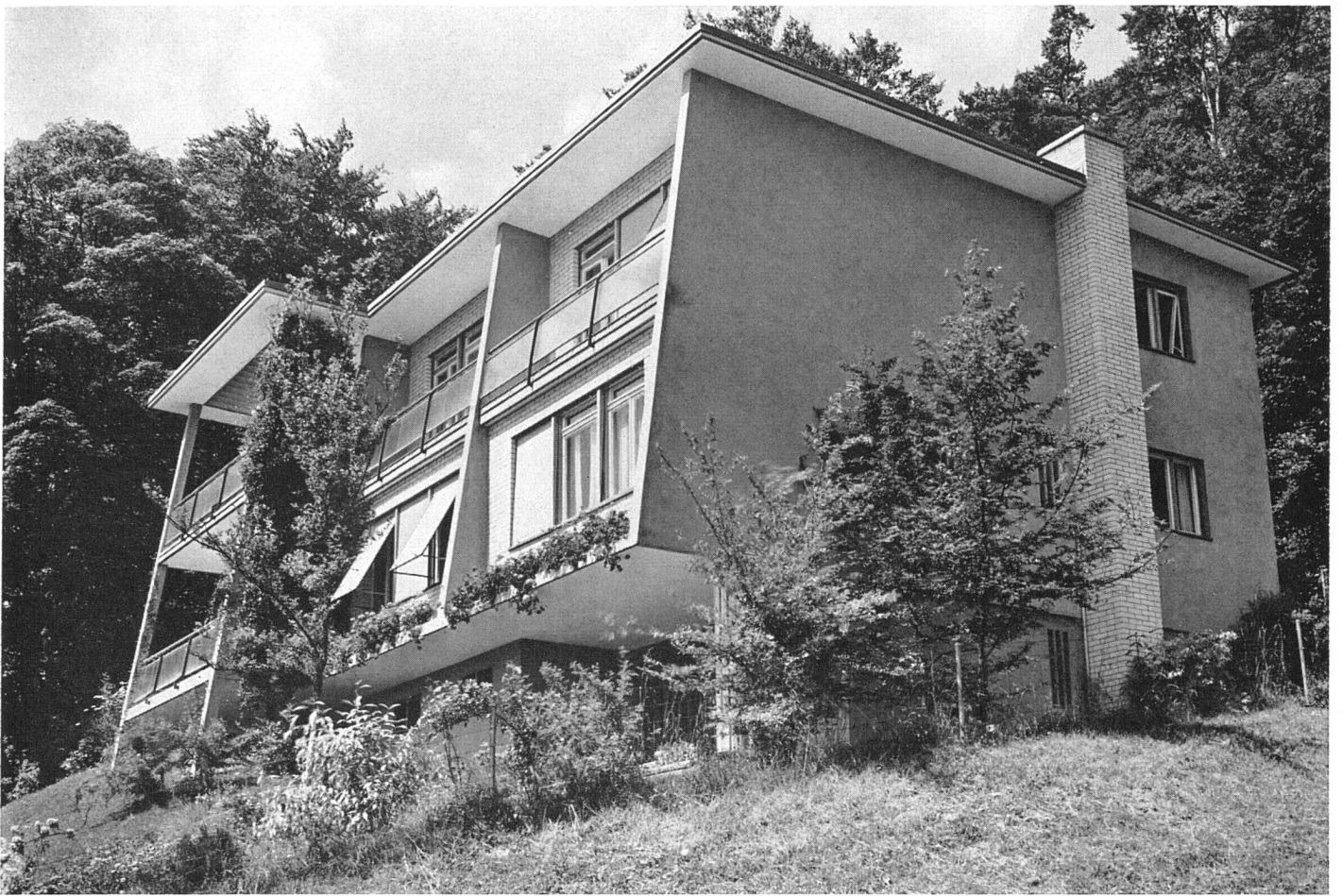
Ansicht von Südosten / Vue prise du sud-est / From the south-east
