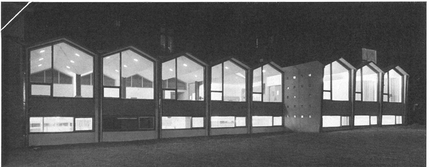
Speiseraum von außen bei Nacht | Extérieur du réfectoire la nuit | Exterior of the cafeteria at night
