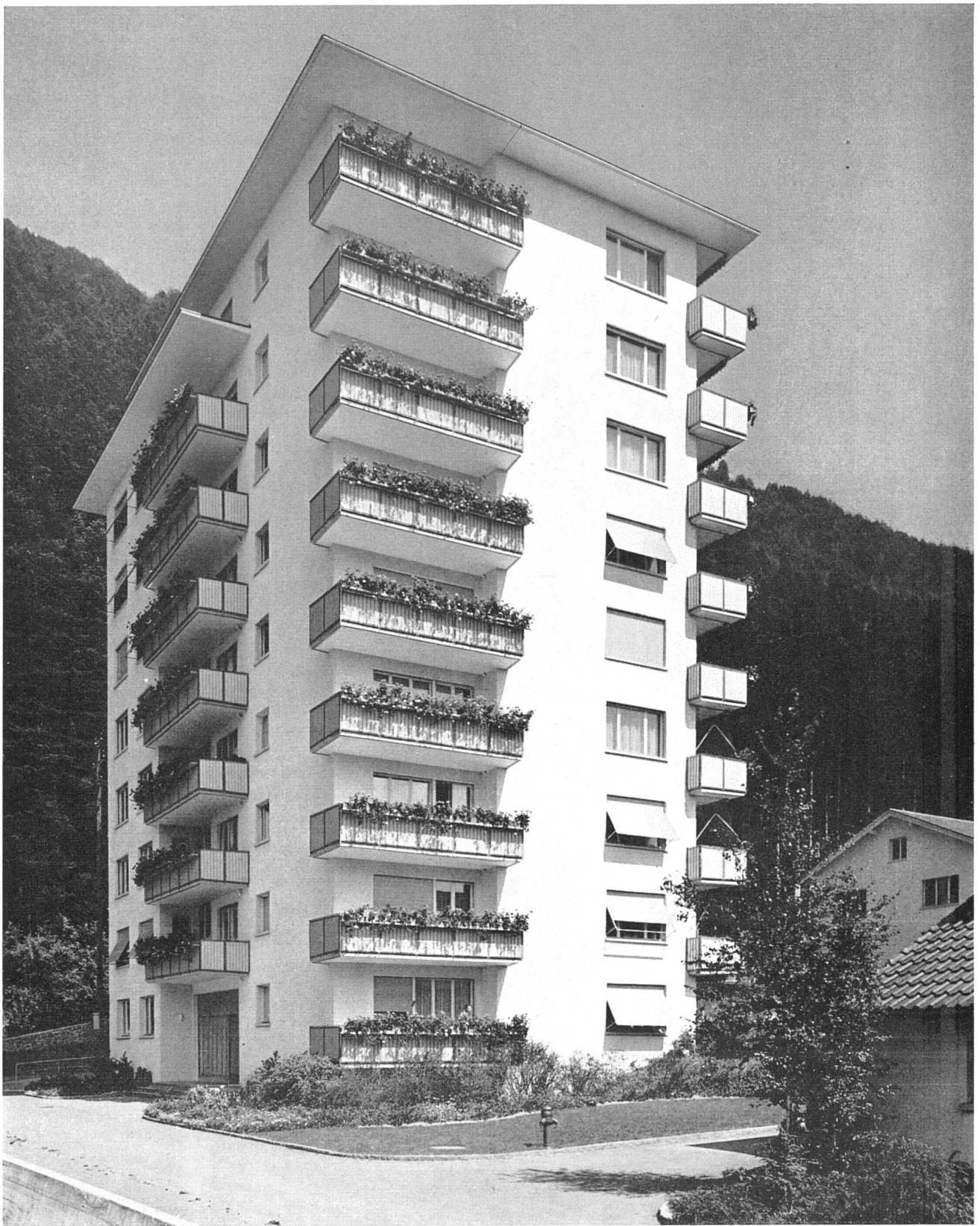
Das Wohnhochhaus von Südwesten | Immeuble à multiples étages; vue prise du sud-ouest | The block of flats from the south-west
