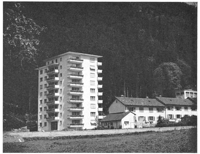
Westansicht | Vue prise de l'ouest | From the west
