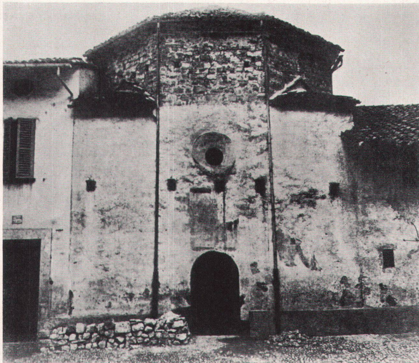
3 Westfassade vor der Restaurierung Le baptistère vu de l'est, avant la restauration The baptistery before restoration, from the west
