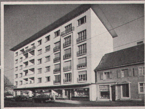
Wohn- und Geschäftshaus Zur Waage Binningen
