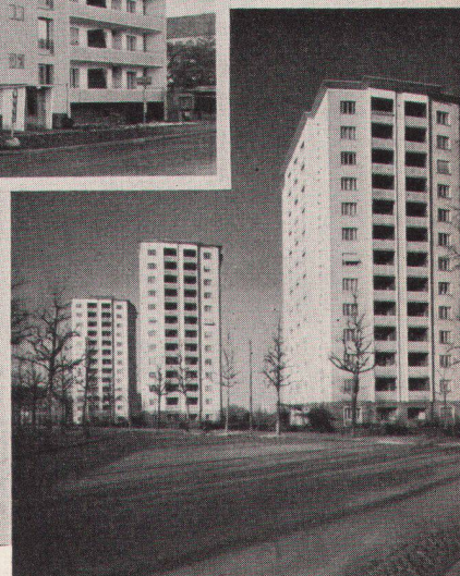
Hochhäuser Enten- weidstr./Mittlerestr.
