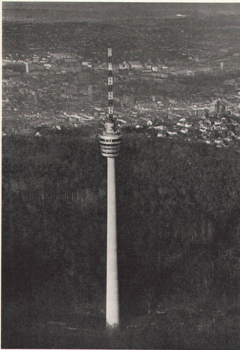
Fernsehturm auf dem Hohen Bopser bei Stuttgart, Höhe 211 m. Pläne: Fritz Leonhardt. Luftbild: Albrecht Brugger, Stuttgart. Freigegeben vom Innenministerium Baden-Württemberg. Nr. 2/1229
