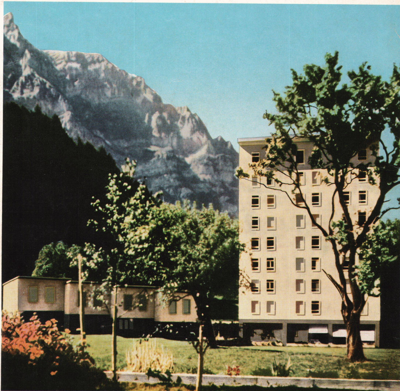
Schwestern- und Personalhaus zum Kantonsspital Glarus Aussenwände in 20 und 25 cm starkem Durisol-Mauerwerk Architekt: Jakob Zweifel, SIA, Zürich/Glarus Ingenieur: Friedr. Pfeiffer, Zürich
