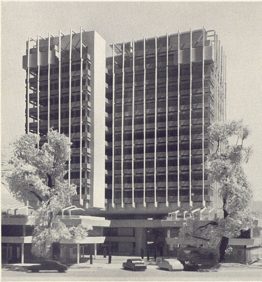
8 Nordseite des Büroturmes Façade nord de la tour-bureaux North elevation of the office point house
