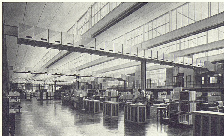
Klimaanlage in einer Tabakfabrik
