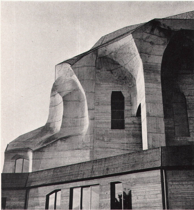
6 Detail der Südseite Détail de la face sud South face detail
