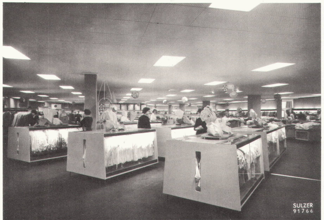
Verkaufsraum eines grossen Warenhauses mit Sulzer- Luftkonditionierungsanlage
