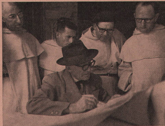
Le Corbusier bespricht mit Dominikanermönchen die Bauarbeiten des Klosters La Tourette Photo: René Buri
