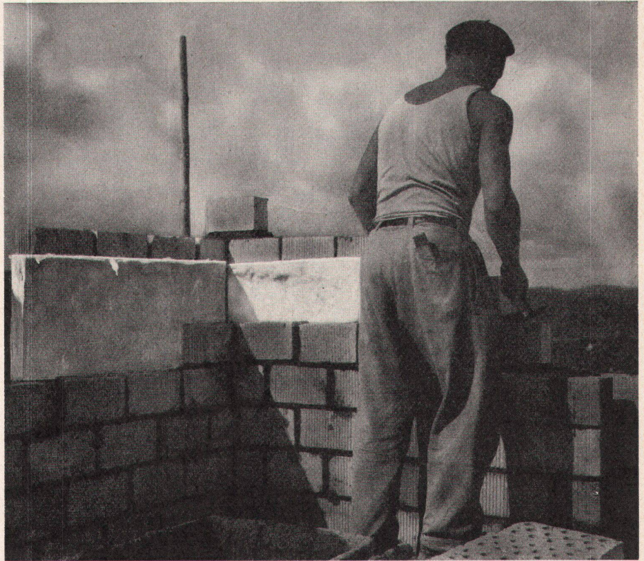
Ausführung eines doppelschaligen Fassadenmauerwerkes; Hohlraum mit SILLAN-Filz ausgefüllt
