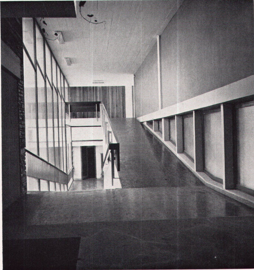
5 Salle de classe. Fenêtres à lamelles et vantaux basculants pour l'aération Klassenzimmer. Fensterlamellen und Kippflügel für Ventilation Classroom. Windows have tilttable side-slats for ventilation
