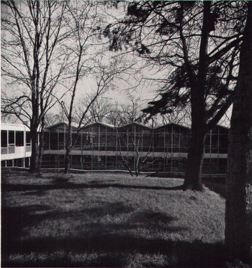
1 Ansicht von Nordosten mit Klassentrakt und Bibliothek Vue prise du nord-est, avec bâtiment des classes et bibliothèque View from the northeast with classroom wing and library
