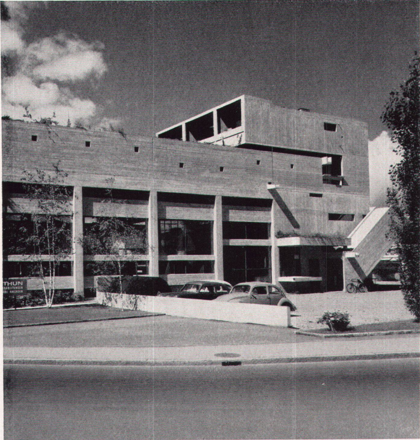
3 Nordostseite mit Eingang zur Fabrikhalle und Ausgang zur Wohnung Face nord-est avec l'entrée du hall de l'usine et l'escalier conduisant à l'appartement du propriétaire Northeast face with entrance to workshop and access to private flat
