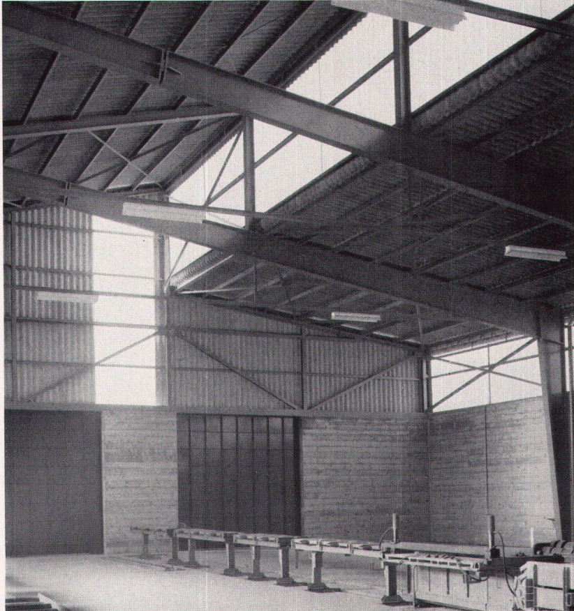
1 Intérieur du hall Innenraum der Halle Hall interior
