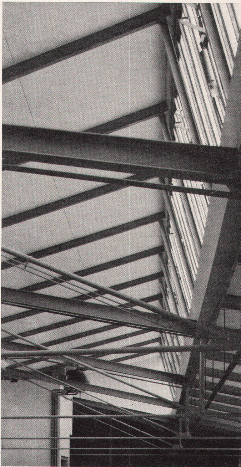
Firma Pestalozzi & Co, Zürich, Neubau Lagerhalle in Dietikon.
