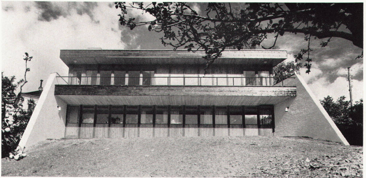
1 Südfassade Face sud South elevation
