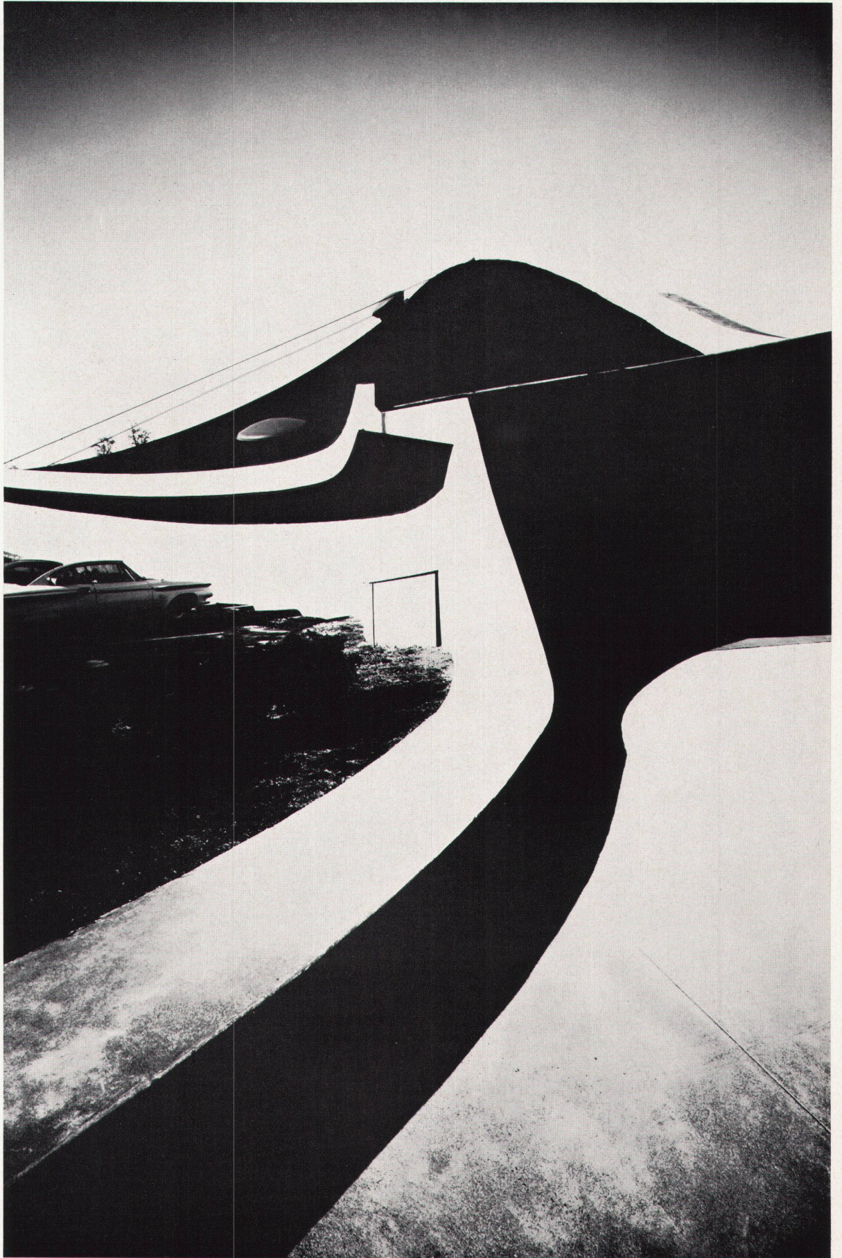
Eisstadion in New Haven. Architekt: Eero Saarinen Patinoire à New Haven Ice-skating rink in New Haven
