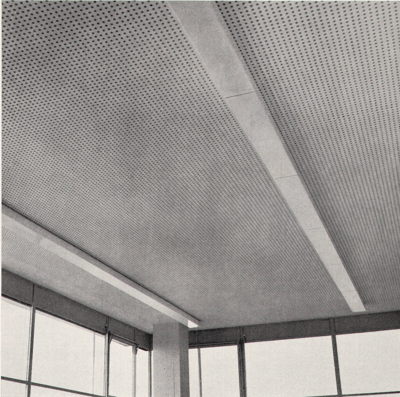
Fugenlose Schallschluckdecke aus Gitro-Platten
