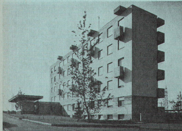
2 2 Eingangsseite des Ledigenheims
