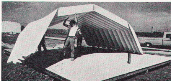
5 Faltkonstruktion für Obdachlosenunterkünfte in den USA Structure accordéon de logements pour sans-abris aux États-Unis Folding shelters for homeless persons in the United States
