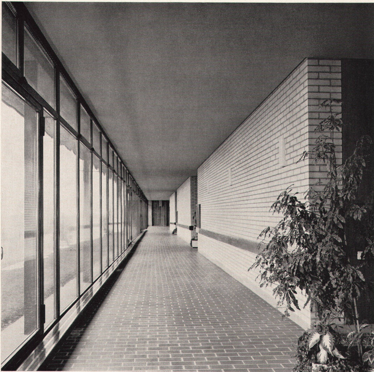
Glatte, heruntergehängte Decke aus Gitro-Platten
