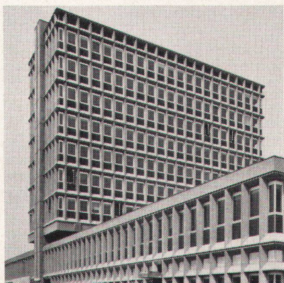
Architekt: Ernest Martin, Genève; Leichtmetallfassade und -fenster: METALLBAU HIRSCH, Biel; Konstrukteur: IGECO S.A., Etoy VD
